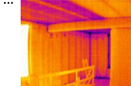
Pont thermique d'une isolation défailante. Apriori défaut de plaquage laissant apparaître une condensation aux liaisons de l'isolant
