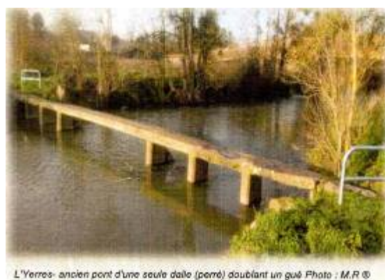
L'Yerres- ancien pont d'une seule dalle (perré) doublant un gué Photo : M.R
