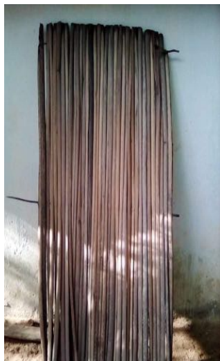
Photo gauche: préparation des tiges de ravinala pour le toit.
