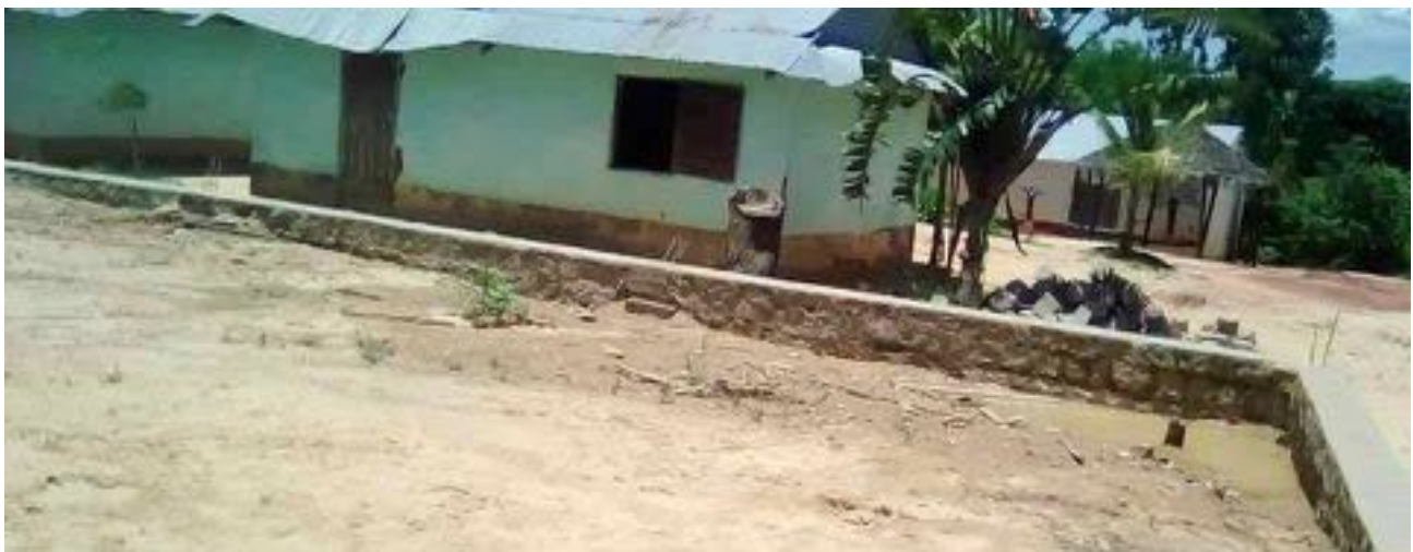
Mur de protection et de drainage terminés
