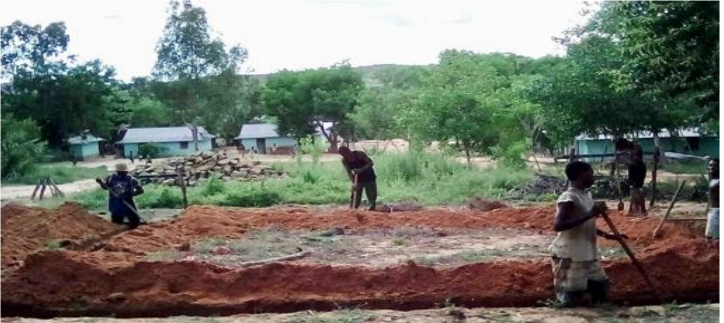
Préparation des tranchées pour les fondations.
