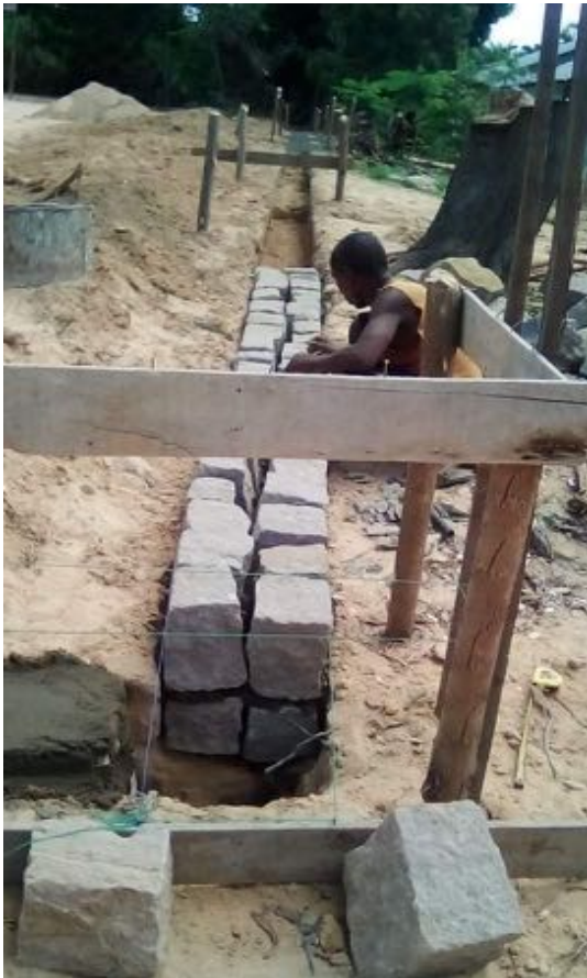
Les différentes étapes de la construction du mur de protection et drainage
