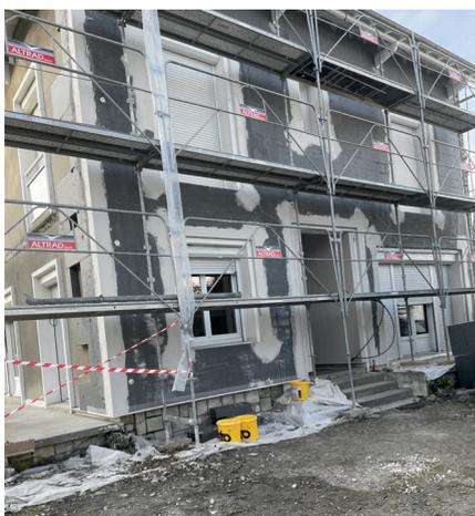
Comme vous avez pu le constater, d'importants travaux de rénovation sont en cours au **presbytère de La Tremblade** : la cuisine a été entièrement refaite en novembre 2022 et actuellement l'isolation extérieure du logement est en cours de réalisation et durera jusqu'à fin février. Ensuite l'intérieur va être refait avec une réorganisation des chambres et salles de bains à l'étage, une rénovation du rez-de-chaussée (électricité, plomberie et peinture), un changement du système de chauffage.
