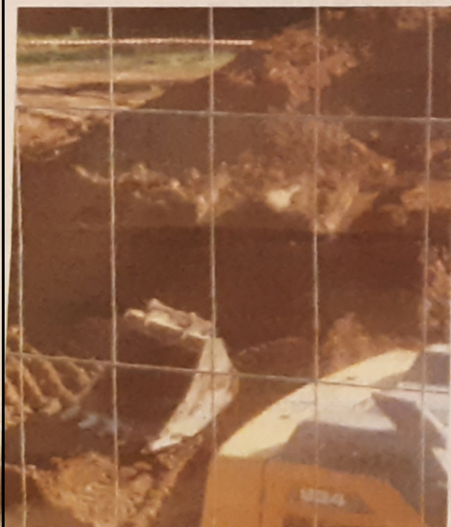
Les travaux de terrassement ont débuté. Photo : Daniel Valdenaire
