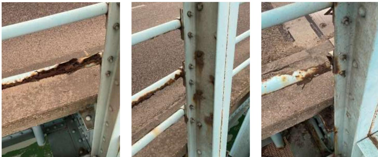
Le 10 mars dernier, nous avons alerté le département de l'Isère sur la corrosion des lisses qui se trouvent de part et d'autre du tablier. Voici la réponse du Service Ouvrages d'Art et Risques Naturels :
