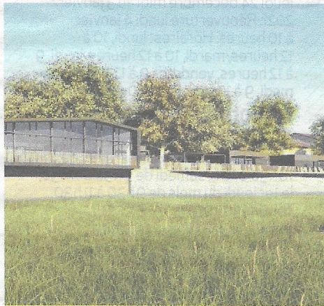
Vue des futures installations depuis le Rhône Photo: Daniel Valdenaire
