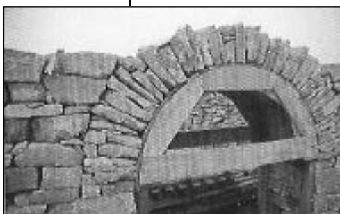
Arc clavé servant de linteau, capitelle du domaine d'Escattes à Nîmes reconstruite par l'Association MENHIR de Courbessac avec le concours de Maurice ROUSTAN
