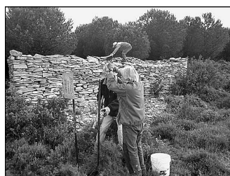
Posse d'une pancarte indiquant que ce travail a été réalisé à partir de 2013 par l'APROMICAV avec le concours des enfants du centre de loisirs
