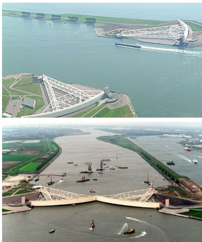
Le Maeslantkering « barrière de protection du pays de la Meuse » à Rotterdam, position ouverte et position fermée. ©CreativeCommons
