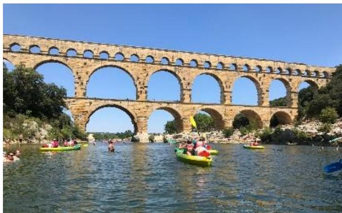
et sur des bâtisseurs. Sur le tracé, le plus célèbre des ouvrages, le Pont du Gard et ses 49 arches, est un édifice esthétique et gigantesque, 275 mètres de long à son sommet, 49 mètres de haut, fait de blocs de roche dont certains dépassent 2<sup>m3</sup> et au total plus de 50 000 tonnes de pierres, il a été conçu pour résister, avec succès, aux crues sauvages du Gardon
