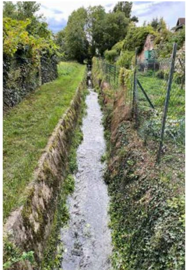
ÉTAT ACTUEL DU BÂTI
