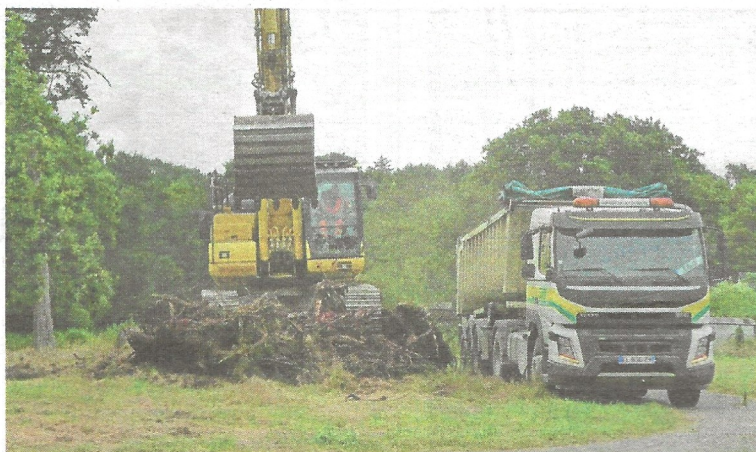
Une ordonnance en date du 22 octobre 2025 qui vient d'être rendue publique lève la suspension des travaux.
