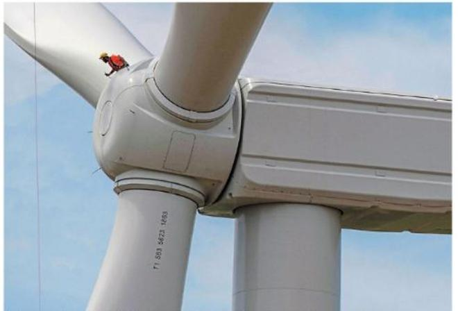
Montage d'une éolienne, avec la fixation à la nacelle, du rotor muni de ses pales, en Ile-et-Vilaine, en juillet 2024.
