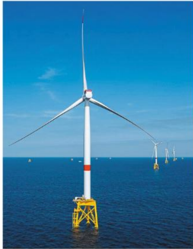
Le parc éolien en mer de la baie de Saint-Brieuc produit de l'électricité à 100 % depuis le mois de mai. (PHOTO: AILES MARINES)
