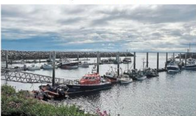
Le ponton n° 1 et le quai, le long de l'envrochement, seront occupés par Ailes Marines. Les autres pontons seront rénovés et agrandis pour compenser les places perdues pour les bateaux de pêche. (PHOTO: QUERRIEN)
