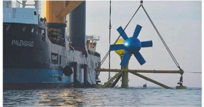
La Bretagne a déjà l'expérience de l'hydrolien. Ici, l'immersion d'une hydrolienne Sabella D10 en 2015 au large de l'île d'Ouessant. (PHOTO : ARCHIVES OUEST-FRANCE)
