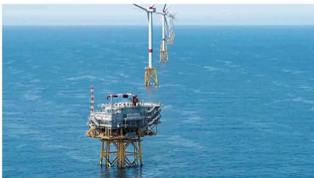
Le parc éolien en baie de Saint-Brieuc, exploité par Ailes Marines.
