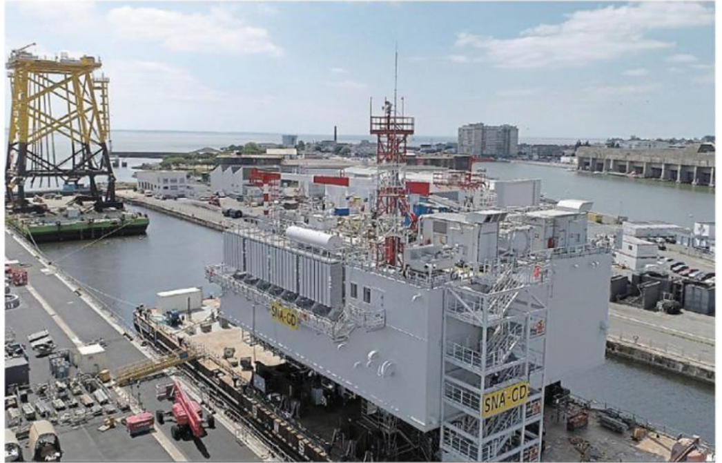
La sous-station électrique du parc éolien marin (au premier plan) lors de son départ de Saint-Nazaire en 2022. Elle est aujourd'hui posée sur son support à une quinzaine de kilomètres de la côte. Elle abrite deux maxi-transformateurs et pèse plus de 3 000 tonnes.
