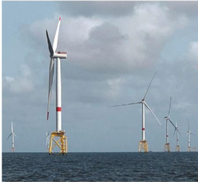
Le parc éolien de la baie de Saint-Brieuc est situé à 16 km au large du cap Fréhel. Il comprend 62 éoliennes de 205 m de hauteur qui délivreront 8 MW chacune. Le chantier devrait être achevé en fin d'année.
