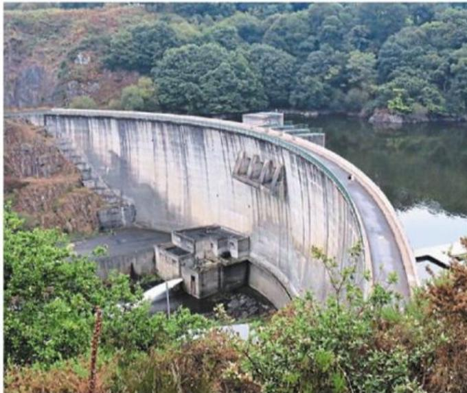
Le barrage de Saint-Barthélemy, entre La Méauçon et Ploufragan, crée une immense retenue sur le Gouët où une prise d'eau a été installée pour alimenter l'usine de production d'eau potable de Saint-Brieuc Armor agglomération.
