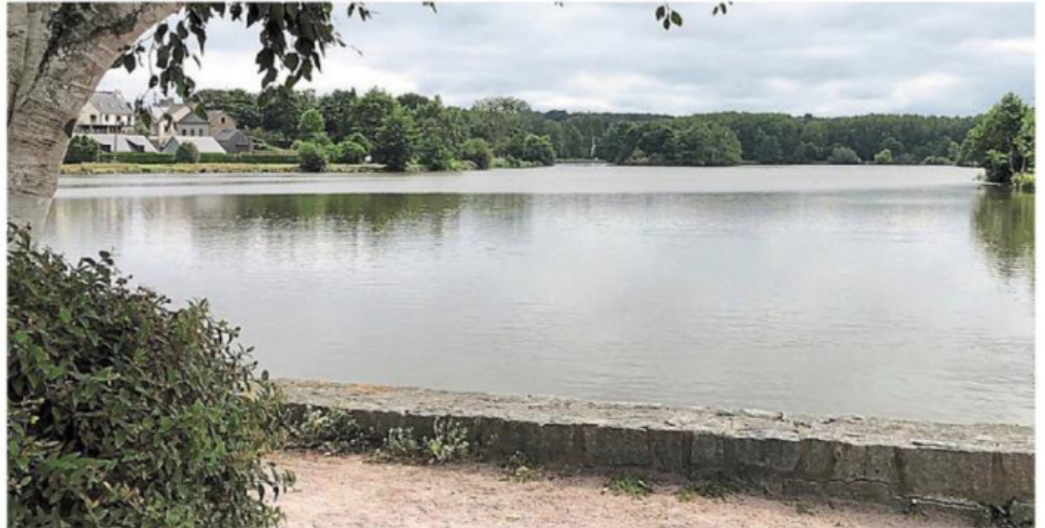
Le sujet des travaux pris en charge par l'Agglo du plan d'eau de la Ville-Gaudu, a créé le débat, mardi.
