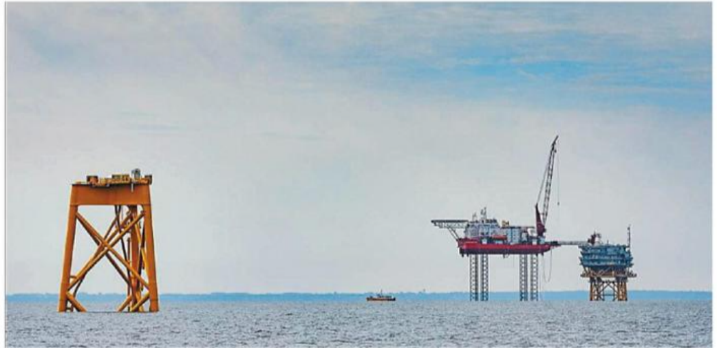
Dans la zone du futur parc éolien de la baie de Saint-Brieuc, les fondations jackets de 24 éoliennes sont installées et la sous-station électrique est en cours d'assemblage.
