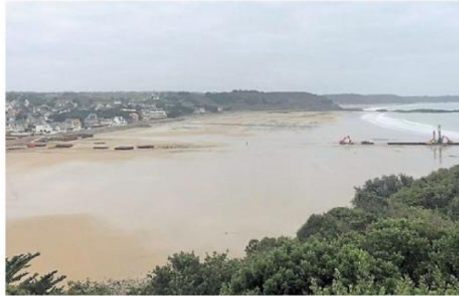
Le chantier de RTE est installé sur la plage de Caroual à Erquy (Côtes-d'Armor). L'entreprise installe les câbles qui relieront le futur parc éolien offshore de la baie de Saint-Brieuc au réseau électrique.
