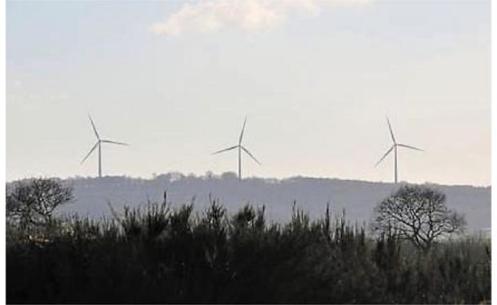
Les quatre éoliennes, situées sur le col de Marhalla, sont visibles à plusieurs kilomètres. Elles mesurent 130 m en bout de pale.
