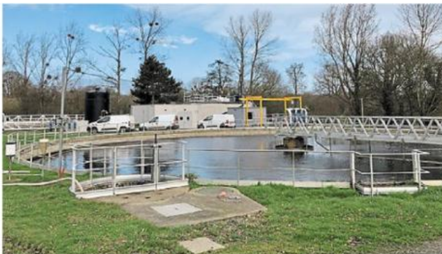
L'unité de traitement des eaux à Souleville, à Lamballe.
