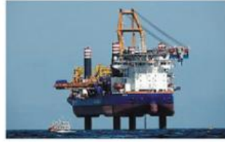
Un navire de forage des fondations des 62 éoliennes. (PHOTO : OUEST-FRANCE)
