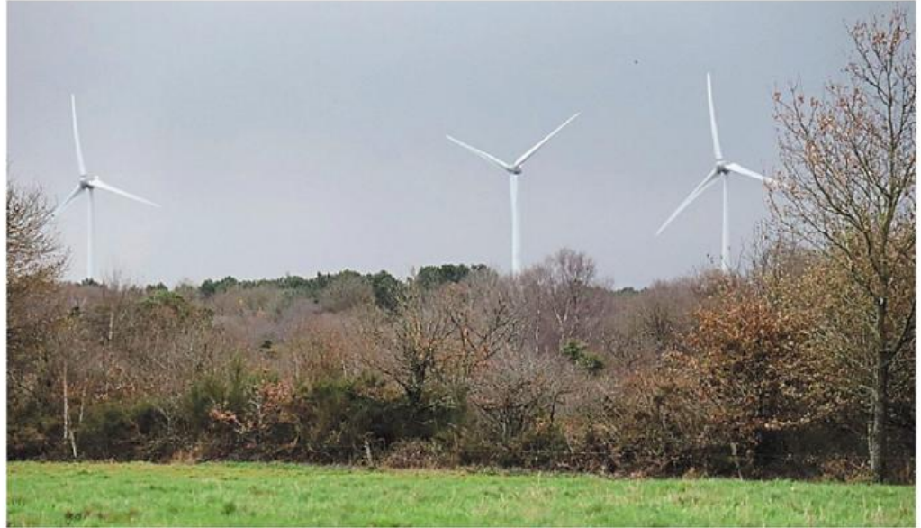
Les premières éoliennes de la Poterie à Lamballe ont été inaugurées en octobre 2012.
