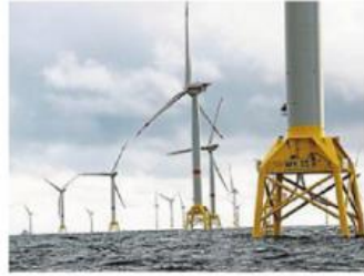
Iberdrola a remporté l'appel d'offres en 2012, via le consortium Ailes Marines, pour construire un parc de 62 éoliennes offshore. | PHOTO: ILLUSTRATION OUEST FRANCE
