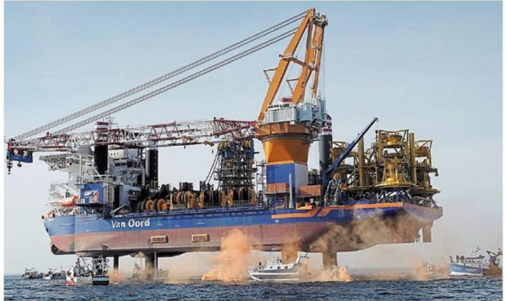
Près de soixante-dix bateaux de pêche se sont rassemblés autour de l' Aeolus de la société Van Oord pour protester contre le début du chantier du parc éolien en baie de Saint-Brieuc.
