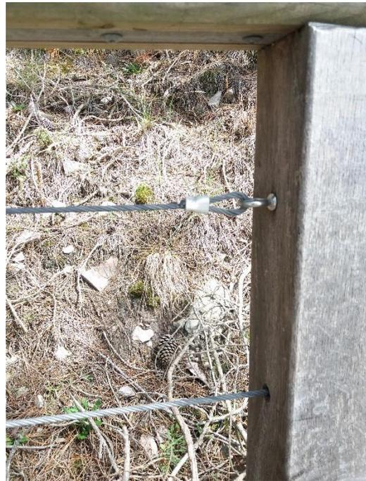
Sur l'escalier du d'accès au CAP les fixations des cables ne tiennent pas.
