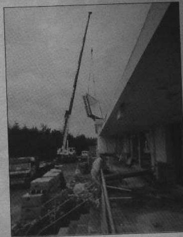
26 juin 1997 : installation de la piscine
