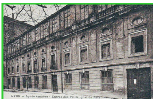
Lycée Ampère À Lyon
