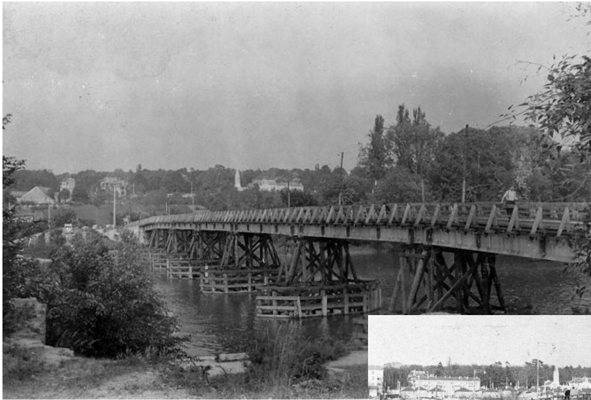
Passerelle reconstruite après la guerre. Piliers de bois sur radier de chêne.
