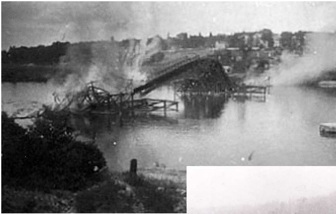
Août 1944, Les Allemands mettent le feu à leur passerelle
