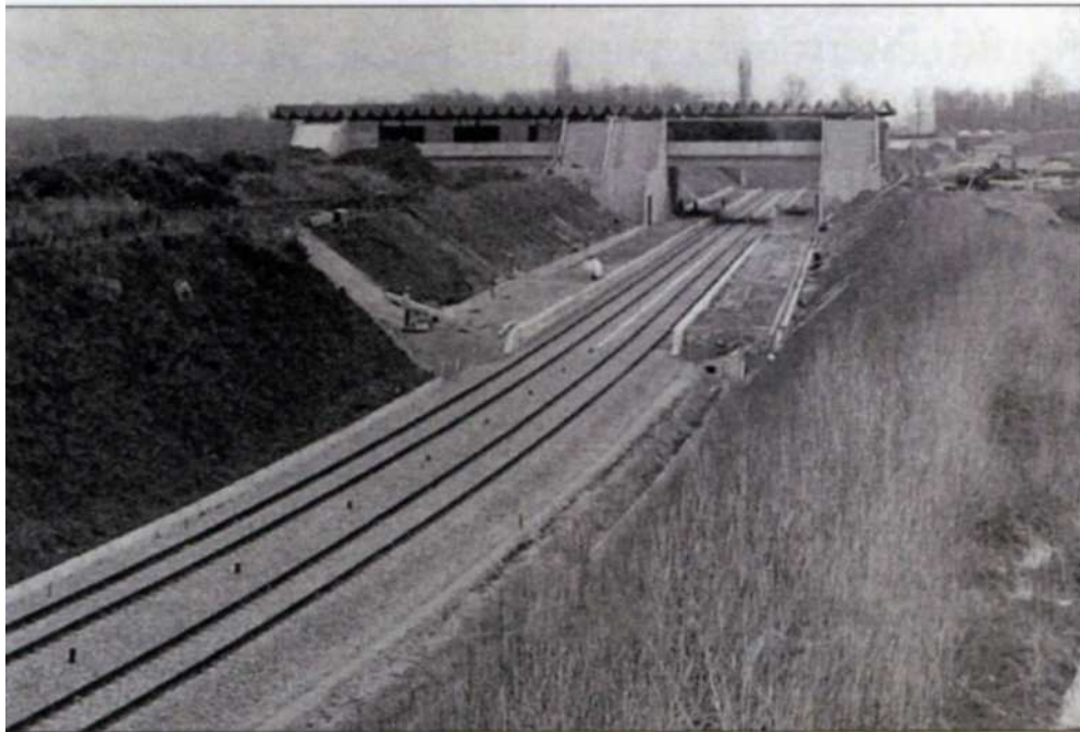
Construction de la gare d'Orangis-Bois de l'épine vers 1974.
