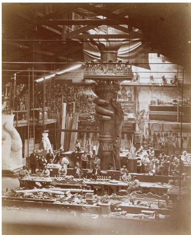
Vue intérieure des ateliers Monduit lors de la réalisation de la main de la statue de la Liberté en 1876 ©RMN
