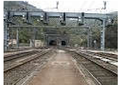
entrée tunnel balitres Cerbere/Portbou
