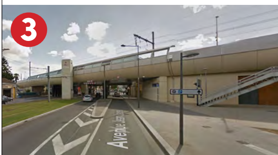
L'accès à la gare SNCF de Cenon
