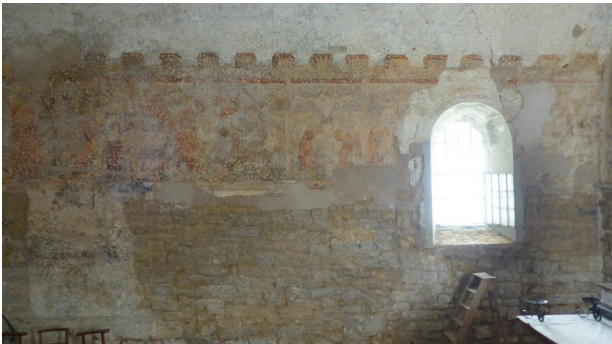
Figure 3 : Mur nord du chœur de l'église de Revigny Cr. : F. CŒUR DE ROI, 2022
