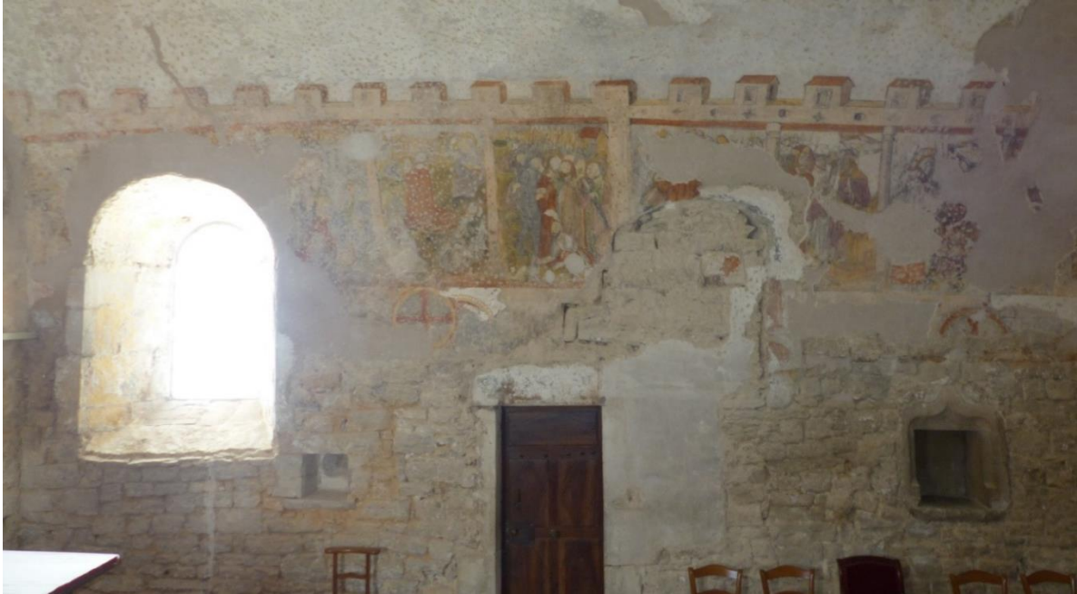
Figure 2 : Mur sud du chœur de l'église de Revigny Cr. : F. CŒUR DE ROI, 2022
