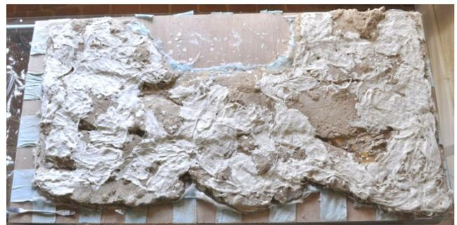
Renforcement arrière du panneau après dépose
