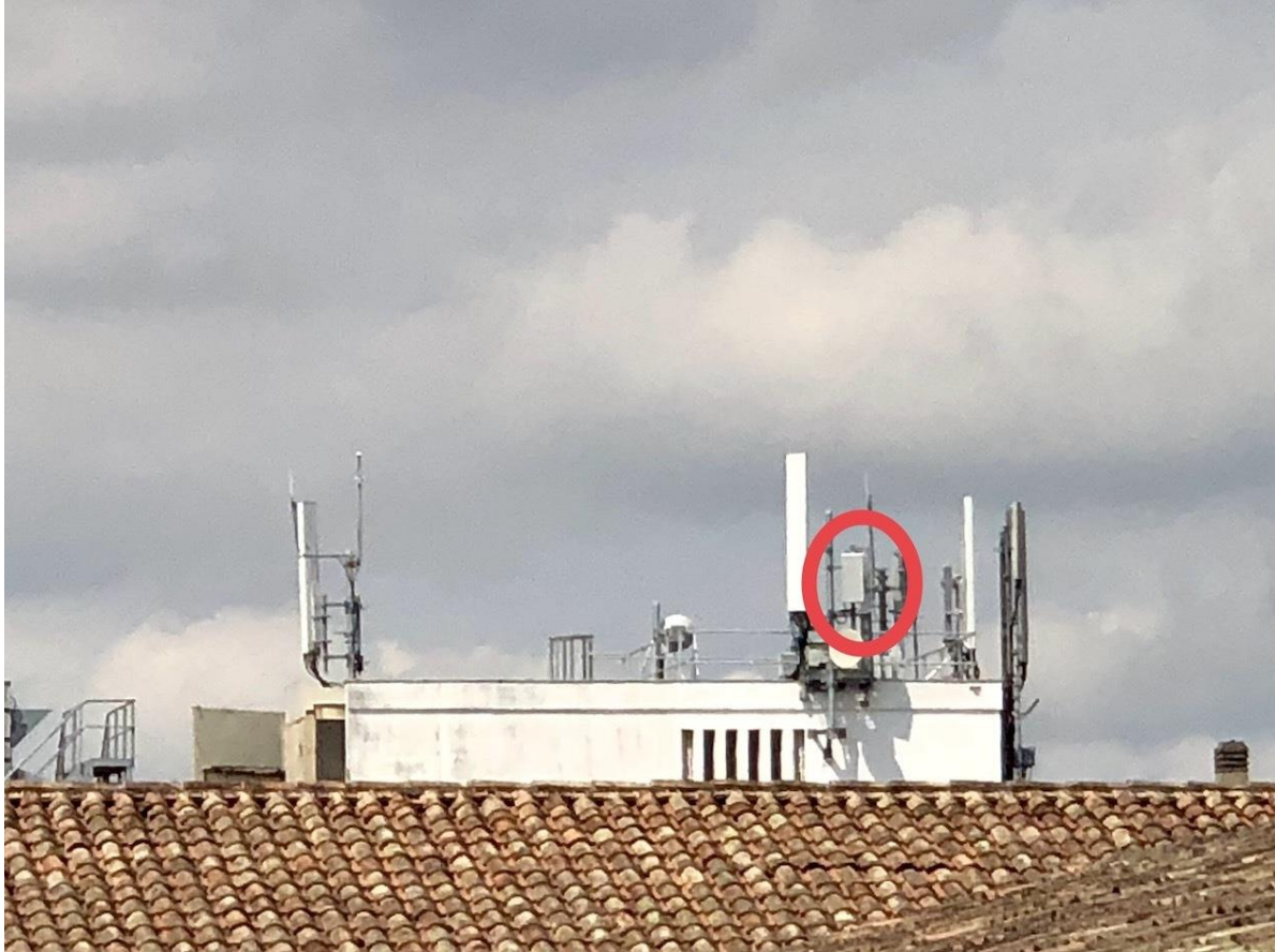
JSZ/01net.com - La première antenne-relais 5G de France est installée en face du CAPC de Bordeaux.
