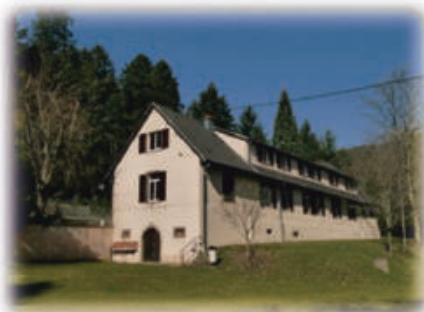
Centre d'accueil du Holzmacheracker.
