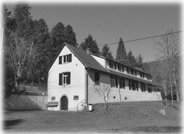
Centre d'accueil du Holzmacheracker.
