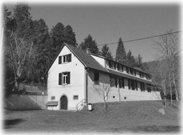
Centre d'accueil du Holzmacheracker.
