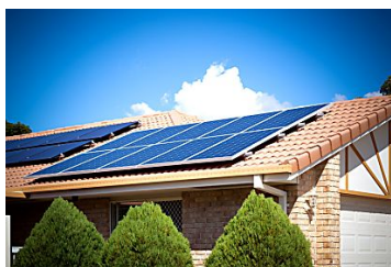
Les panneaux solaires sont-ils rentables ? (Mon Energie Solaire)
