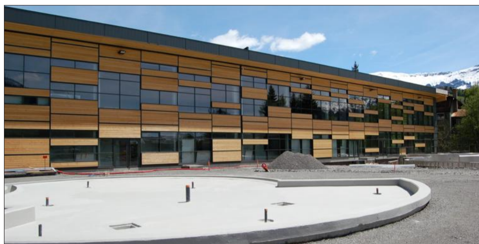
La future pataugeoire est presque achevée, comme la façade du bâtiment de balnéothérapie, dont le bassin extérieur prend forme. Photo Le DUE.P.-M.
