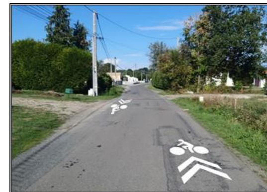
Jalonnement simple ou renforcé (1 - 5 k€/km)
