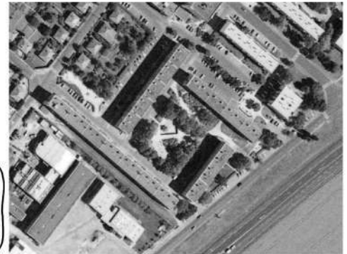
Démolition de l'immeuble rue Bernard Palissy en 2019
