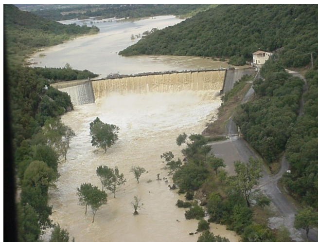
Barrage écrêteur de crue de la Rouvière lors de la crue du 9 septembre 2002, supérieure à sa crue de projet de sûreté. Source AIGREF 19
