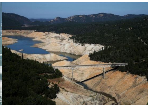
Barrage en Californie
