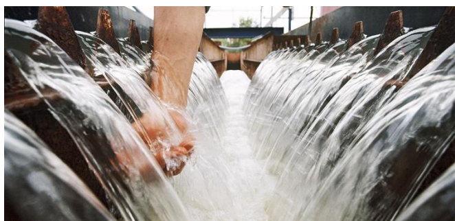
Station d'épuration à Colombes dans les Hauts-de-Seine. Michel BARET/Getty Images
