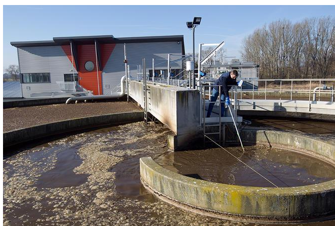
L'activité bactérienne, obtenue notamment grâce au procédé des boues activées, permet une dégradation des pollutions carbonées, azotées et phosphorées. Frederic MAIGROT/REA
