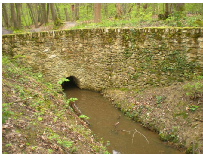
L'ouvrage d'art du Croisement permettait à l'eau du réseau aérien de passer au-dessus du réseau technique. Ce curieux aqueduc de 29 m a été restauré en 2007. (Photo A - 26 avril 2016).
