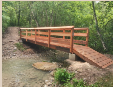
Passerelle rénovée entre Le Percy et Monestier du Percy
